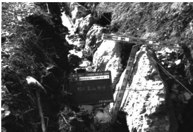
写真5 工事中の環境保全型水路 巨石を組み合わせ積み上げている
