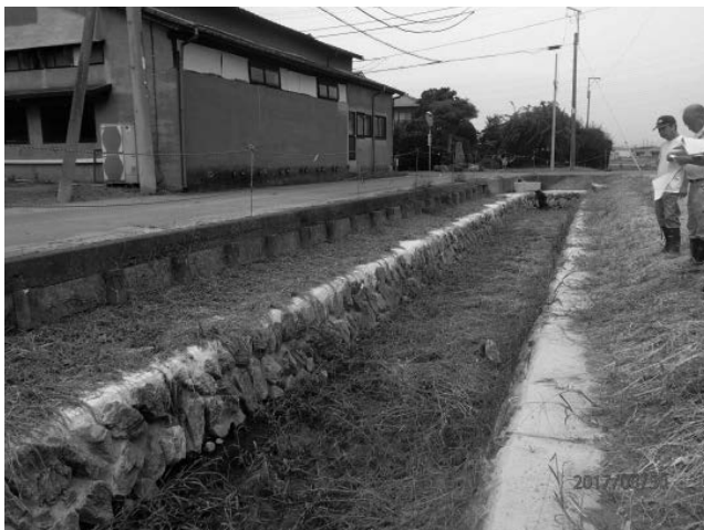
写真11 下戸塚地区の完成した環境保全型水路 (2018.08.03)
